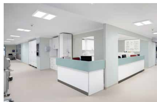
Recepción y salas de espera: Luz perfecta gracias a UGR < 19 y difusor de PC.
